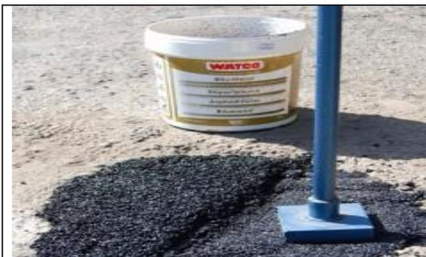
Sollen größere Löcher verschlossen werden haben wir 2 Alternativen. Für provisorische Lösungen bzw. Probleme auf nicht oder nur langsam befahrenen Oberflächen einen Fertigasphalt im Eimer; für dauerhafte Lösungen auf Straßen und Fahrbahnen ein Produkt palettenweise in Säcken von Swepeco. Teurer als handelsübliche – dafür aber eine dauerhafte Lösung.
