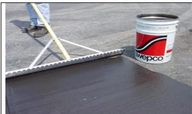
**SWEPCO Asphalt Resurfacer** ist eine einkomponentige, gebrauchsfertige Emulsion aus Gummi, Bitumen, Fasern und Sand zur Neubeschichtung verwitterter Asphaltoberflächen; Wird aufgeschüttet und mit einer Rake verteilt. Verfüllt Risse und Löcher; gute Anhaftung auf vorgereinigten Böden; Verbindet sich dauerhaft mit dem Untergrund; Schrumpft nicht und schützt vor Frostschäden. Gebinde mit 23 lt. reicht für 5-10 m<sup>2</sup> - je nach Oberflächenstruktur
