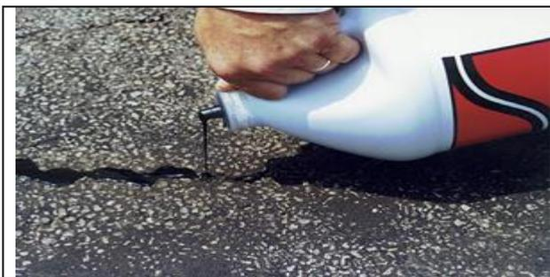
**SWEPCO Leak Füller** ist ein flüssiges Bitumen zum Auffüllen von Rissen und kleineren Löchern im Asphalt ehe die Fläche beschichtet wird.
